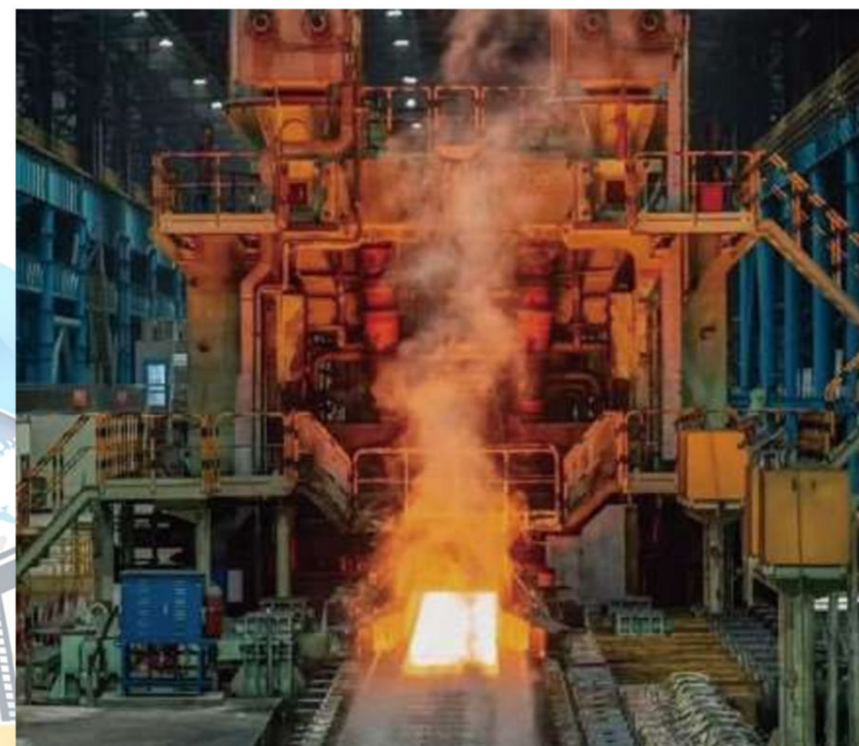
Équipements de production d'acier à grande échelle.
